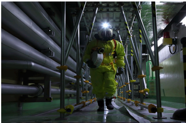
蒸発乾固対策におけるホース展張
