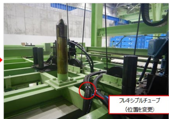
廃棄物を収納する輸送容器を取り扱う設備が移動しても接触しないように、フレキシブルチューブの位置を変更 (チューブの損傷を未然防止)
