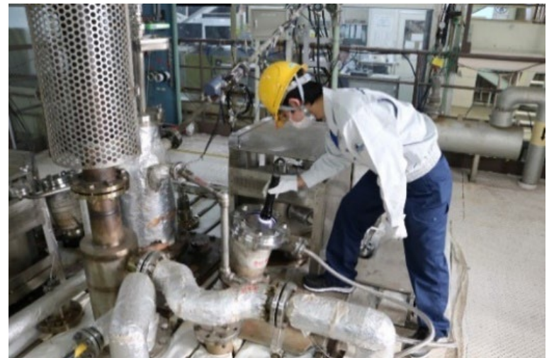
溶融炉内の確認
