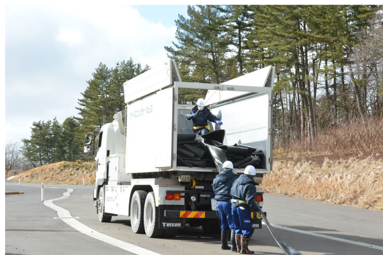
大型移送ポンプ用ホース展張
