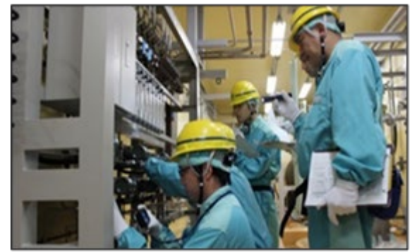
設備・機器把握のための現場確認 (再処理工場)
